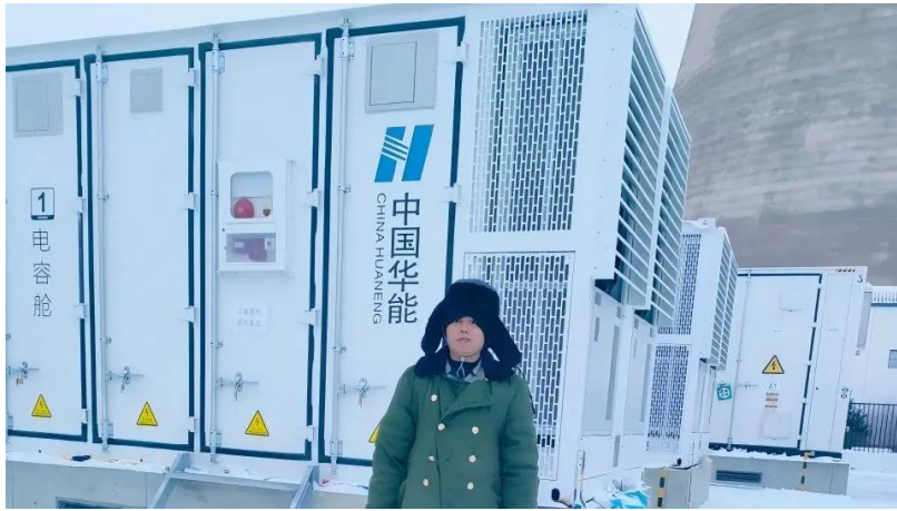
项目负责人李新在华能伊敏项目现场
