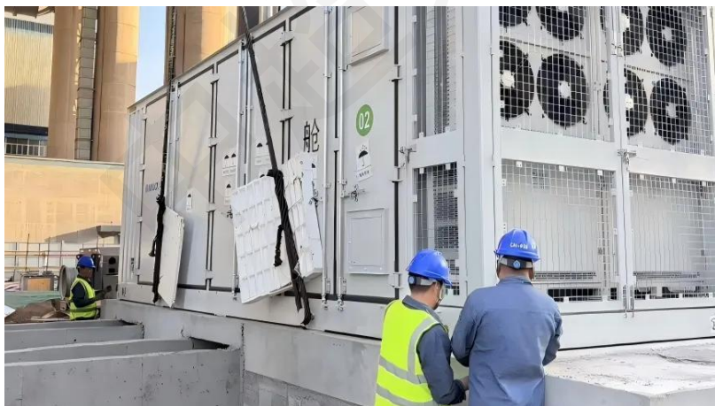
项目团队现场调试设备
