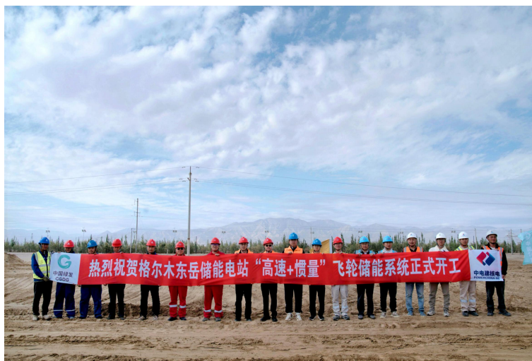
中国绿发20兆瓦飞轮储能项目开工现场。
